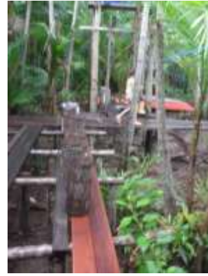
Foto 3: Matapi sobre a ponte.
