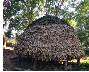
Fig.36. Finalização do telhado
