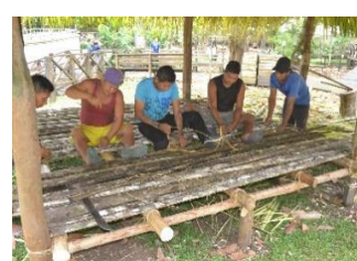
Fig.10. Construção do assoalho
