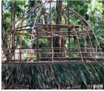
Fig.34. Inserir das palhas
